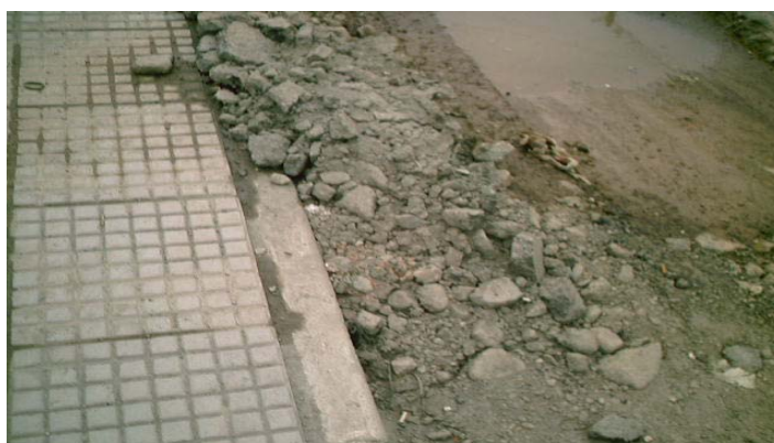
Fig. 11 - Situação do asfalto na Avenida Monte Castelo – via de circulação dos caminhões de lixo
